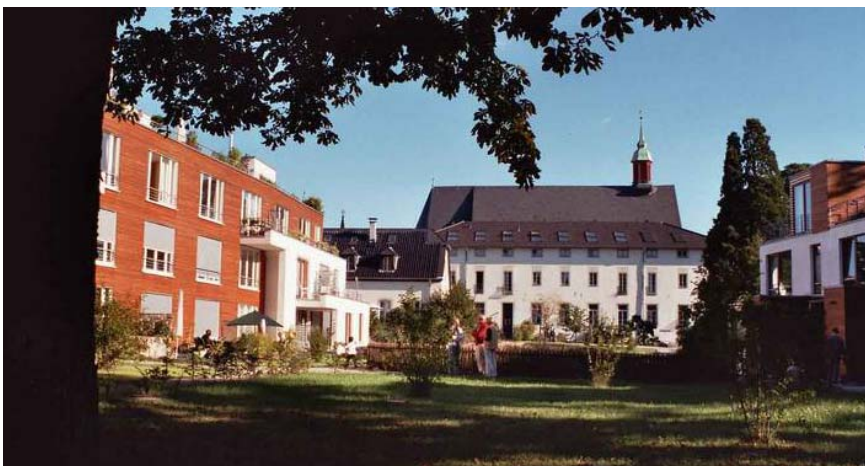
Abbildung 44 Bonn-Pützchen, Umbau Karmeliterkloster zu Generationen-Wohnanlage
