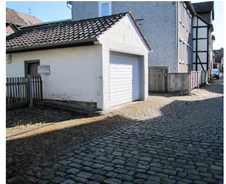
▲ Bsp. Stellplatzsituation Grabenstraße
