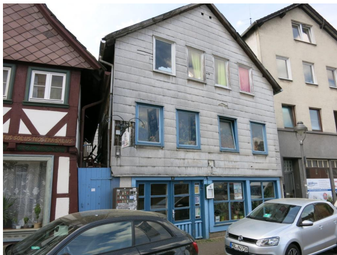
Abbildung 48: Gebäude mit Sanierungsbedarf
