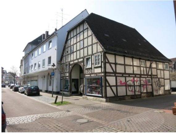
Abbildung 46: Gebäude mit Sanierungsbedarf
