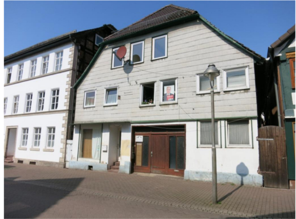
Abbildung 45: Gebäude mit Sanierungsbedarf
