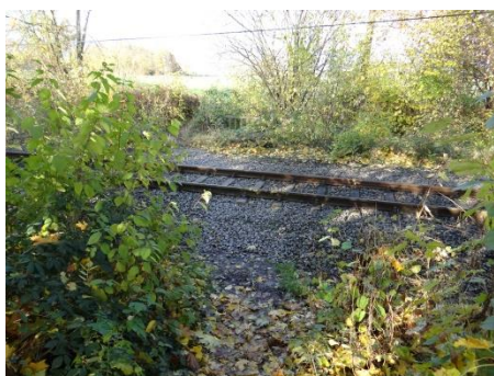
Nicht ausgebaute Wege (Trampelpfad über Schienen)
