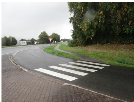
Allersheimer Straße von Liebigstraße bis KVP, Gehweg auf der Südseite (keine Beschilderung für Radverkehr)
